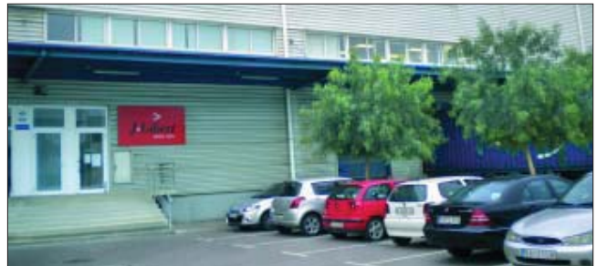
Las instalaciones de J. Gibert en la ZAL del puerto de Barcelona suman 450 metros cuadrados de oficinas y cerca de 5.000 de almacén
